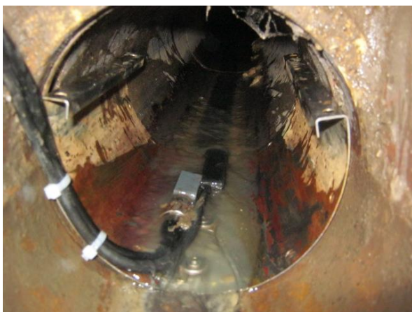
Drucksonde und Kombisensor - Messstelle 10
